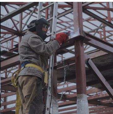
Строительство, монтаж металлоконструкции
